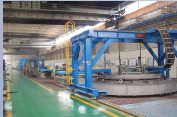
热处理渗碳炉
